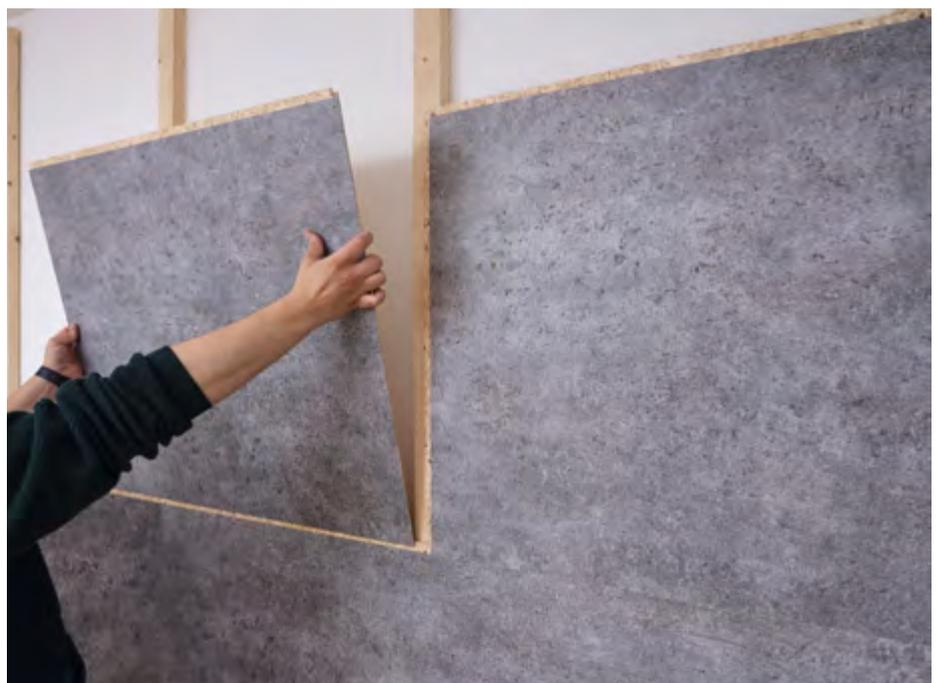
Die EGGER DecoWall ist mit einem umlaufenden Nut- und Federprofil ausgestattet, wodurch sie sich schnell, sauber und optisch nahtlos verlegen lässt (Rovigo Beton ...)
